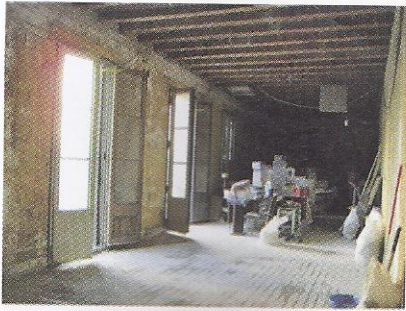
Antes de reparar la cola de impacto
